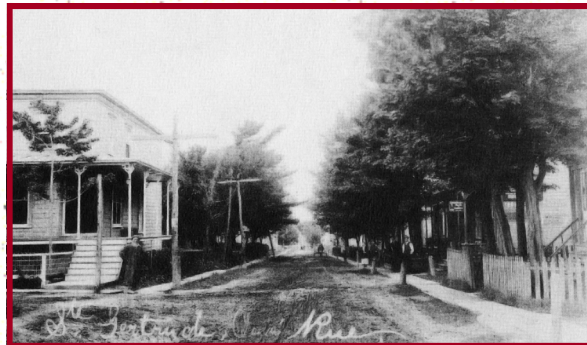
Auteur inconnu, photo tirée du livre Sainte-Gertrude 1945-1995 , ouvrage collectif, 1994.
